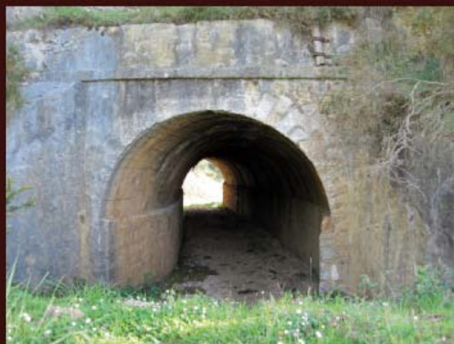
Túnel próximo a las instalaciones de la Cota 100.
