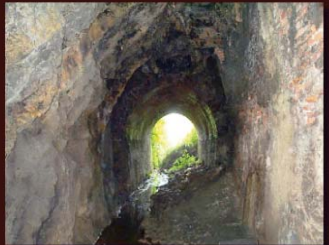
Interior de uno de los túneles.
