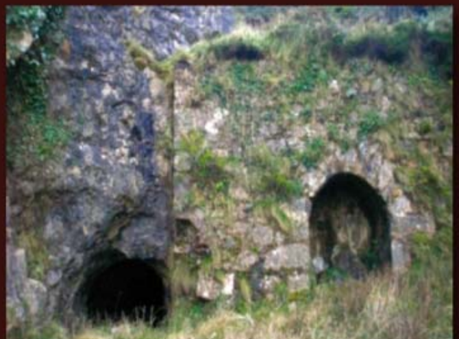
A la izquierda bocamina de La Turbia contigua a las paredes del depósito de mineral con el túnel de carga.
