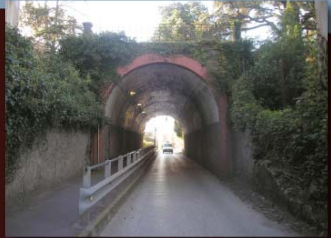
Boca Norte del túnel de Ocharan.
