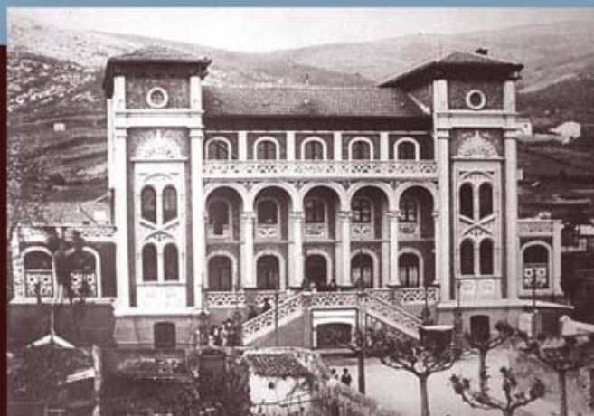
Estación de ferrocarril de Castro. Inaugurada en 1902. Es proyecto de estilo historicista de Eladio Laredo y en su fachada se incorporan cerámicas de Daniel Zuloaga. Es demolida en 1974.
