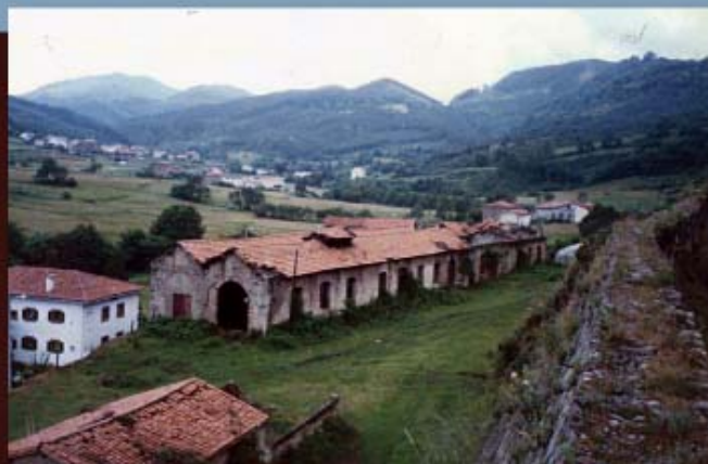
Los talleres de mantenimiento de la Compañía Minera en 1994.
