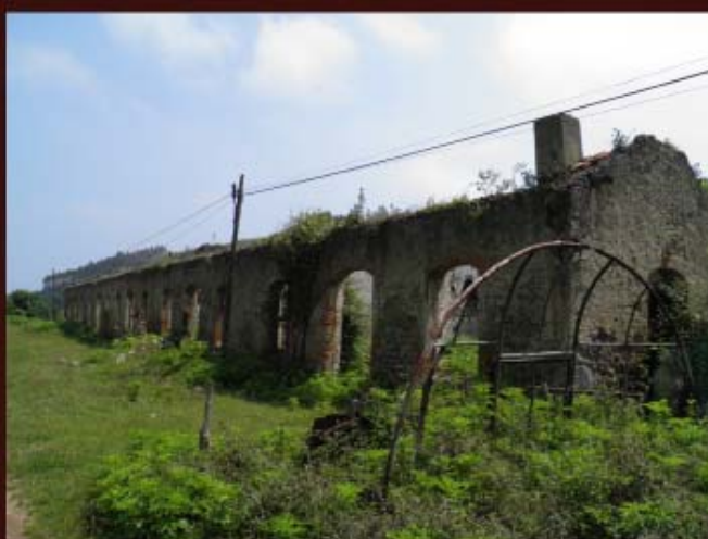
Vista de las ruinas al pie de la vía minera de Setares
