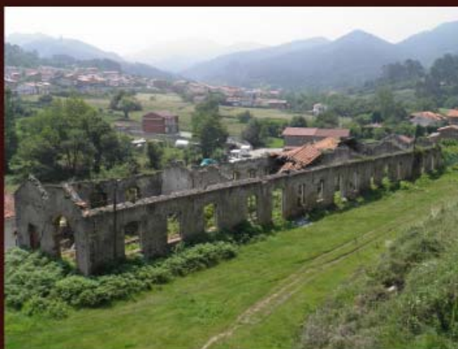
Restos de los Talleres del Manzanal en la actualidad. El edificio se ha convertido en una ruina a pesar de estar protegido por el Plan General de Ordenación.
