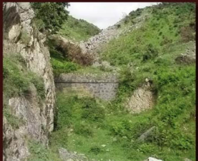
Muros de contención del segundo de los depósitos de mineral de La Turbia.
