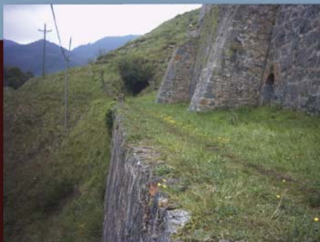
La vía minera a la altura del depósito de La Cercazosa, entre el barrio del Manzanal y la iglesia de Ontón.
