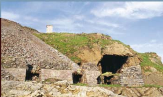
En primer plano se observan los muros de lo que fue el primer cargadero de Piquillo. A la derecha hay una gran oquedad que penetra en los acantilados.
