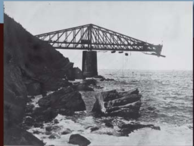
Zona de transporte y carga de mineral mediante vagones de cadena flotante y ferrocarril de adherencia.
