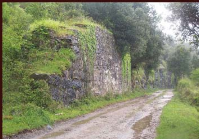
Muro del depósito de La Carmelita I junto a la vía verde.
