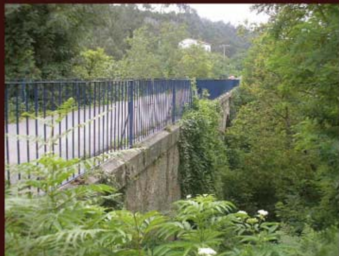
Entorno del puente de San Juan.
