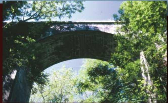
Vista del puente desde el río Cabrera (1996).
